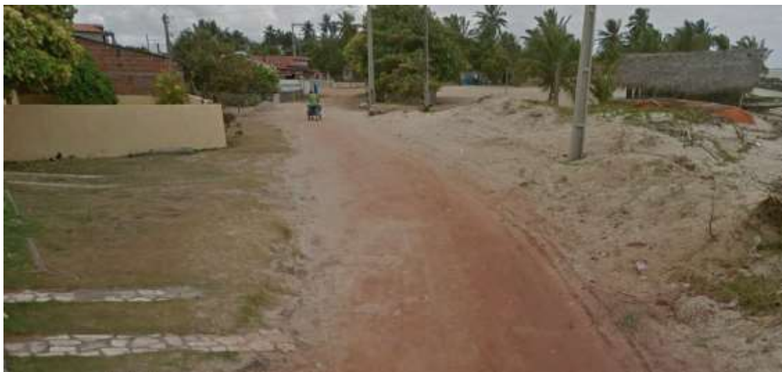
Imagem 02: Rua Santo Antônio
