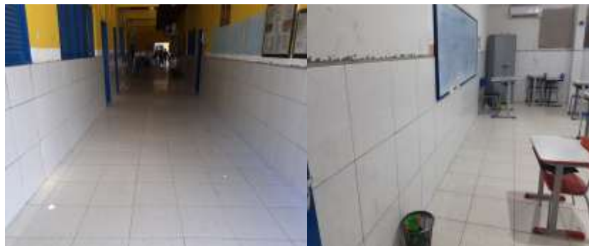
Revestimento com cerâmicas no piso, parede das salas de aula e corredores
